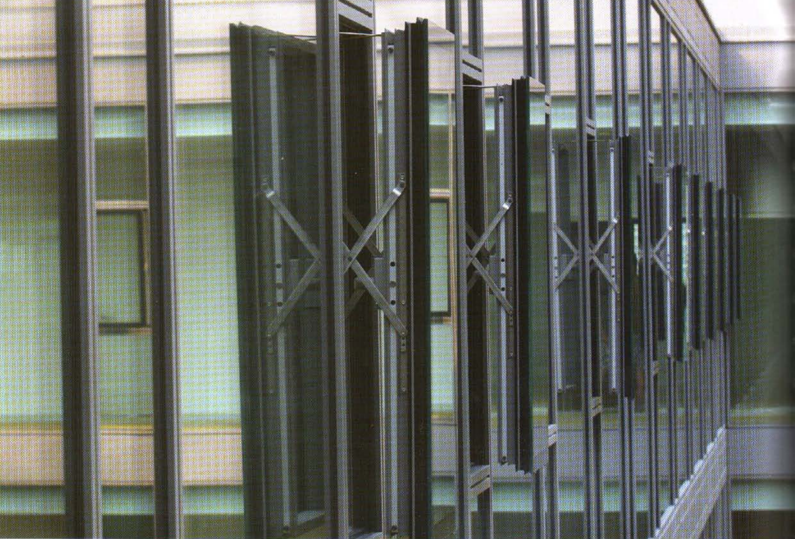
Okná na fasáde novostavby Slovenskej sporiteľne v Bratislave
